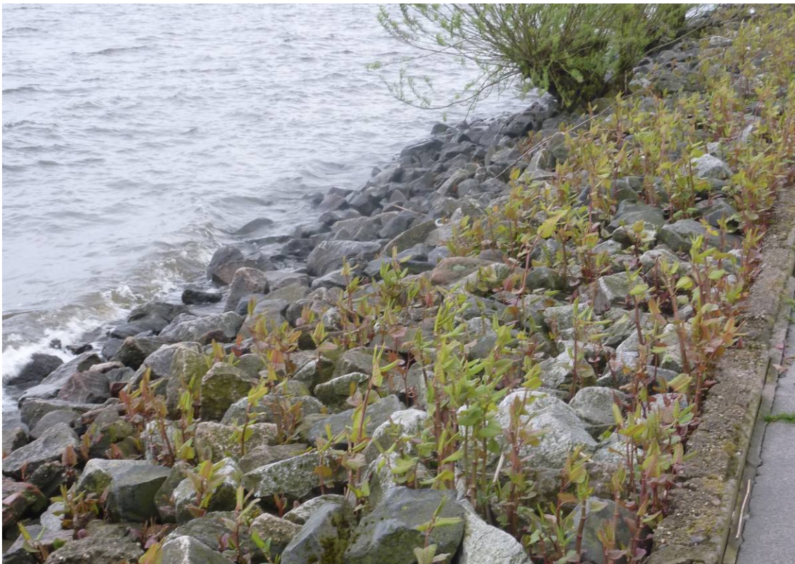
Abbildung 2: Japanischer Staudenknöterich in befestigtem Ufer der Elbe bei Blankenese
